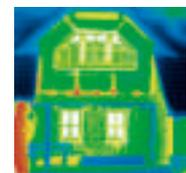
**Wärmebildaufnahmen:** Rot zeigt die Wärmeverlustbereiche. Je stärker die rote Farbe, umso höher ist der Wärmeverlust an den einzelnen Bauteilen.
